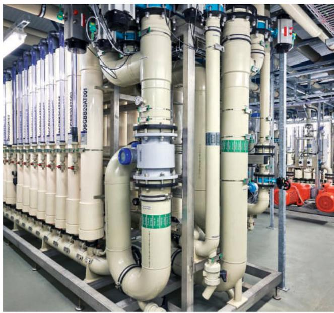
Ultrafiltrationsanlagen können auch Fluss- und Abwasser zu Prozesswasser aufbereiten.
