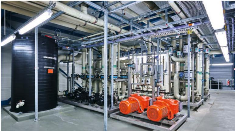
Die Aufbereitung von Abwasser zu Prozesswasser mit Membrantechnologien senkt auch den Frischwasser-Bedarf.
