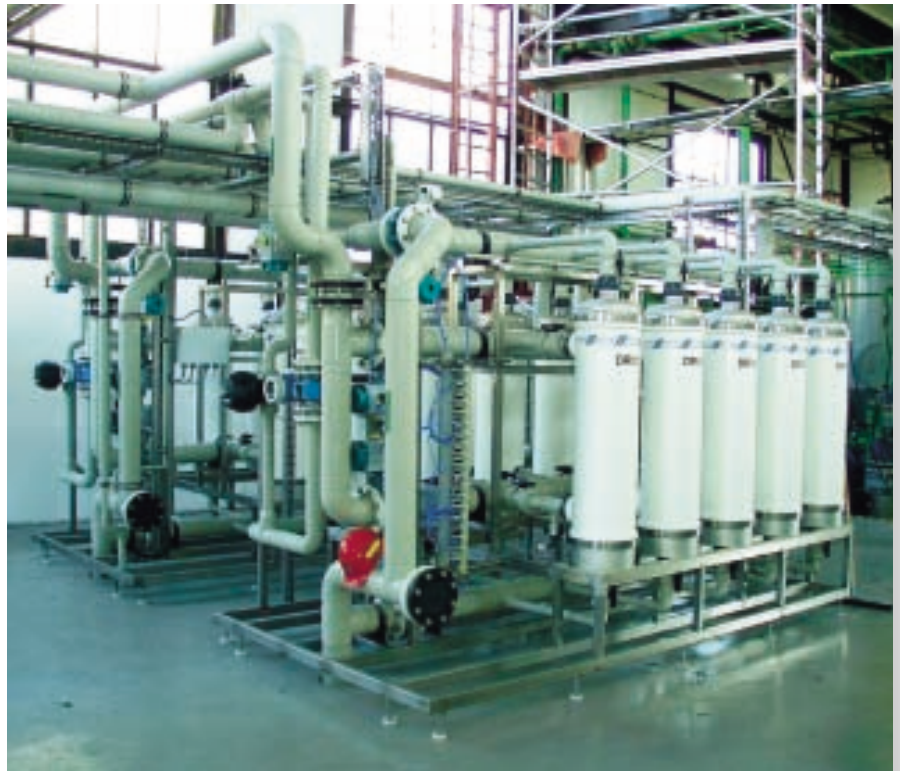
1: Kernstück der Wasseraufbereitungsanlage: zwei baugleiche Blöcke für die Ultrafiltration
